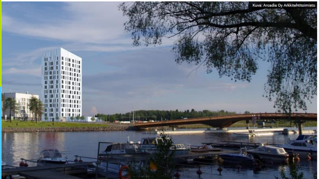
Kuva: Arcadia Oy Arkkitehtitoimisto
