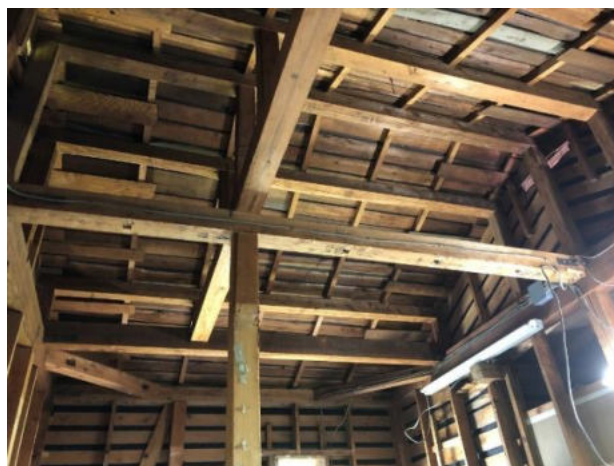
写真 29 トイレ棟 (解体後) 梁の加工を確認する。
