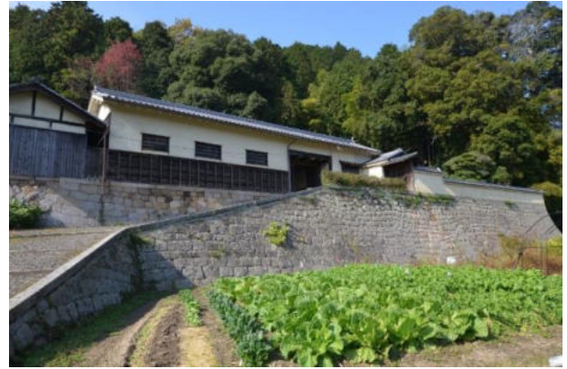
写真1 小山田邸長屋門
