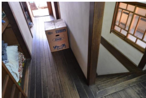
写真 33 階段まわり（改修前）
