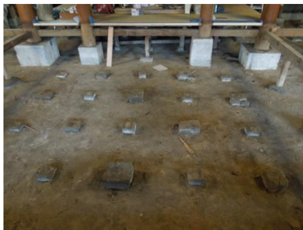
写真11 既存畳・床板・根太・大引きを撤去した後の床下
