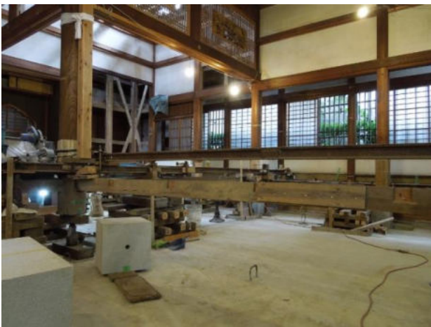
図 2-2 床下の補強（揚屋で建物ごと持ち上げる）
