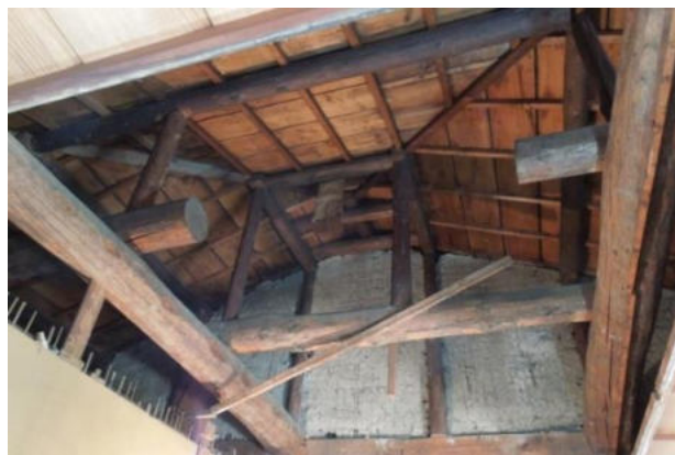
写真 32 解体後、棟札を発見
