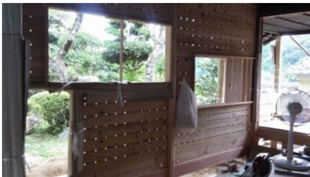
写真2 内露地（施工中）
