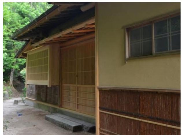
写真 21 外観（改修後）新たに設けられた玄関
