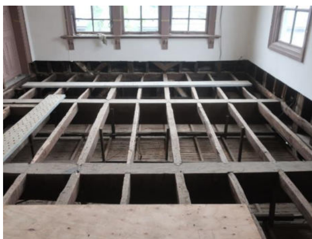
写真 18 2階床下 水平構面を確保するべく調査
