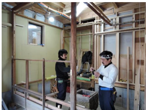
写真9 移築中の大土地庵
