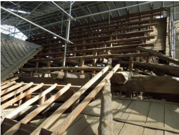
図 2-1 小屋裏の補修（小屋組みと枯木を補修する）
