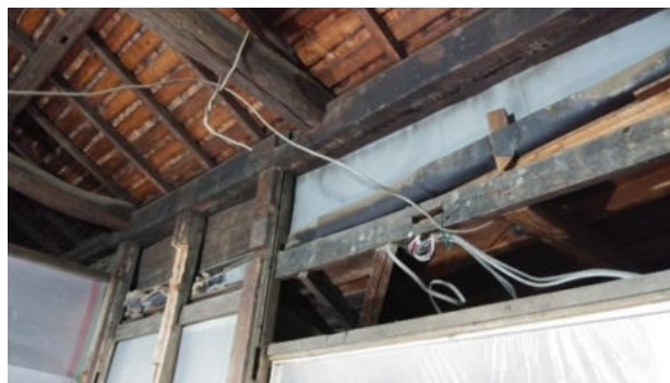
写真 28 客殿・部分解体後 2 梁の加工を確認する。
