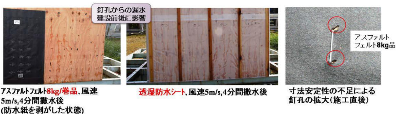
図 1-5 a : 釘孔と漏水
