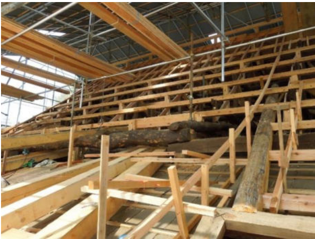
写真 15 補修後の小屋組
