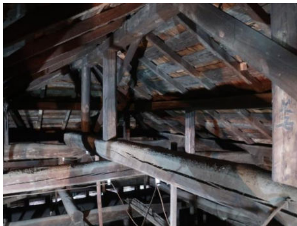
写真 19 小屋裏の調査
