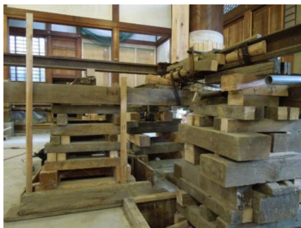
写真12 揚屋の様子 鉄骨レールで固定された上屋を枕木で上げていく。
