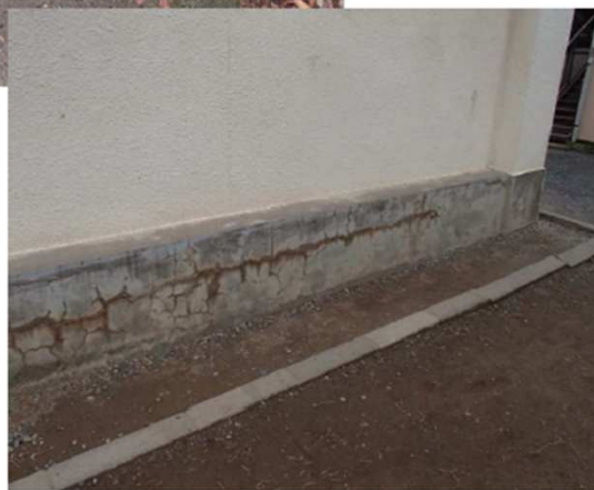
【ひび割れ～錆汁】
