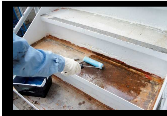
①モルタル撤去
